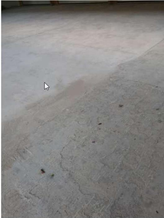
Im Vordergrund der Estrich, bevor er gefräst wurde, gefräst im hinteren Teil des Bildes
