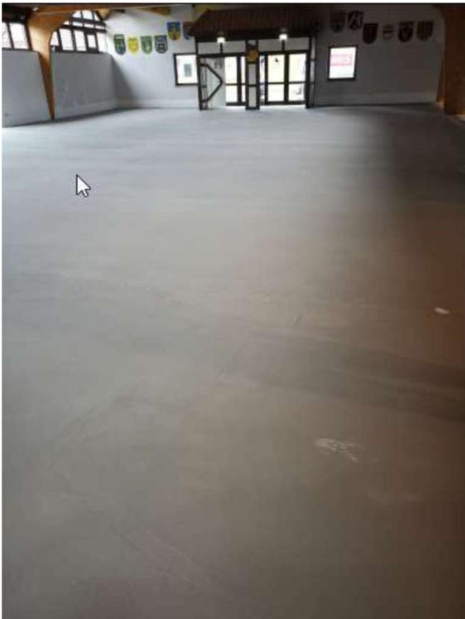
Zum Abschluss der Vorarbeiten wurde eine Ausgleichsmasse aufgetragen
