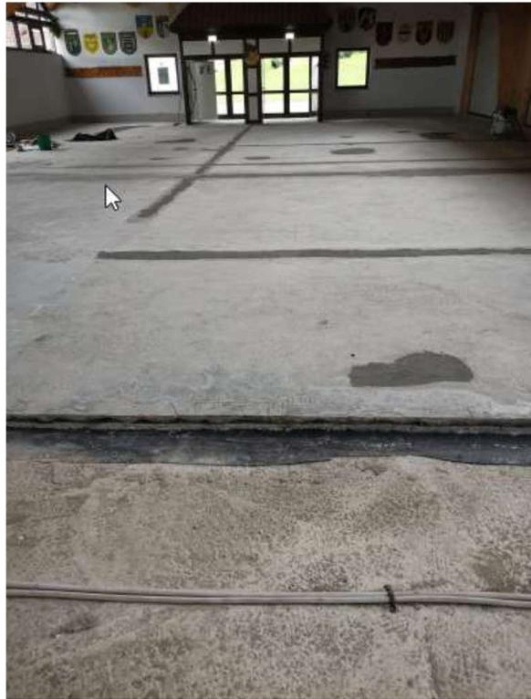
Der fehlende Estrich wurde durch Firma Mrozek eingebracht, die diesen mit einem Zusatz versetzt hat, damit der Estrich schneller trocknet.
